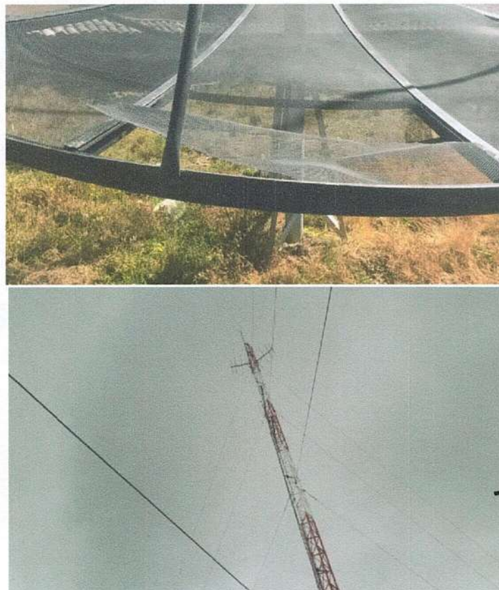
Ilustración 4,5. Sistema radiante necesita mantenimiento preventivo y correctivo Se tienes que hacer Mantenimiento de antena parabólica, cambio de pétalos y pintura de soportes. También se puede verificar que no hay cerco perimétrico para protección de equipos.
