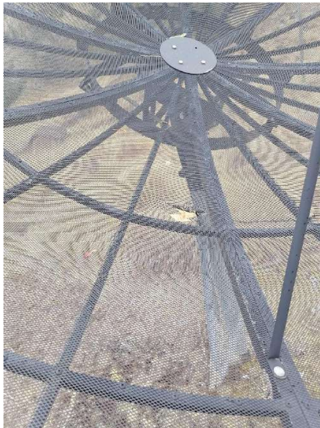
Imagen 5. Antena parabólica presenta un pétalo roto que requiere cambio.
