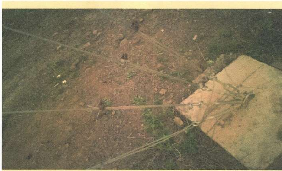
Ilustración 9. Cambio de grapas así como engrasado en grilletes.
