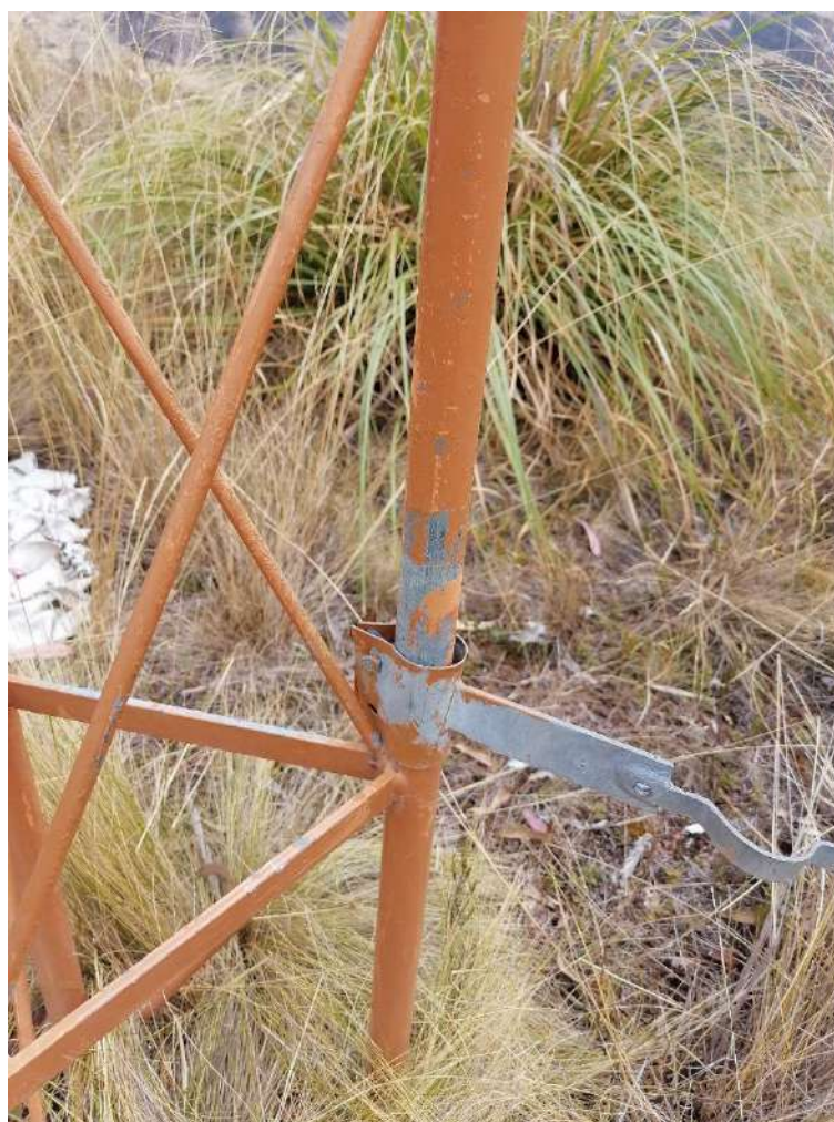
Imagen 4. Cuerpo de torre requiere pintado de acuerdo a los colores reglamentarios según MTC.
