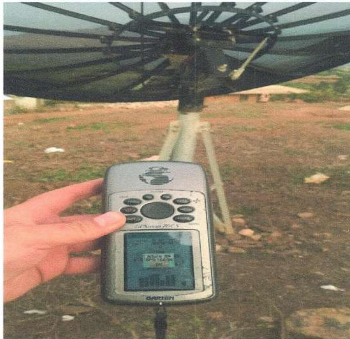
Ilustración 7. Se tiene que hacer Mantenimiento de antena parabólica, cambio de pétalos y pintura de soportes. También se puede verificar que no hay cerco perimétrico para protección de equipos.
